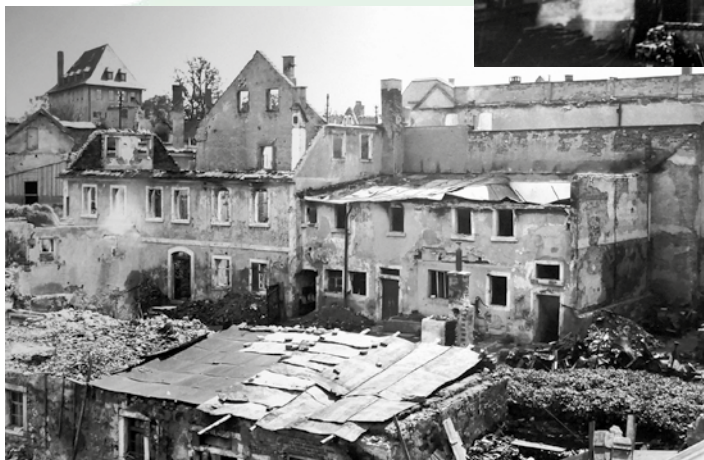
Hinter den stark zerstörten Häusern sieht man das unversehrte Fürstenhaus der Burg. Oben rechts die zerstörte und ausgebrannte Elisabeth-Kirche.
